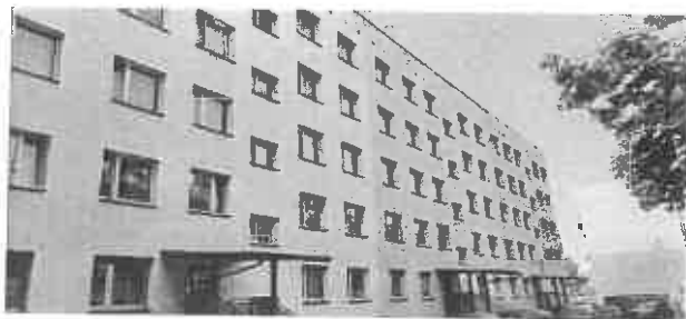
Docieplenie budynku przy ul. Brzechwy 7
