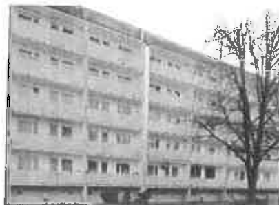
Remont balkonów przy ul. Racławickiej 3D
