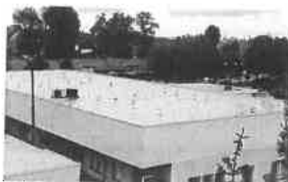
Renowacja dachu pawilonu przy ul. Makuszyńskiego 5 (tzw. zimny dach)
