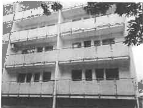
Wyremontowane balkony w budynku przy ul. Kłodnickiej 105
