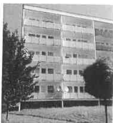
Wyremontowane balkony w budynku przy ul. Gojawiczyńskiej 14
