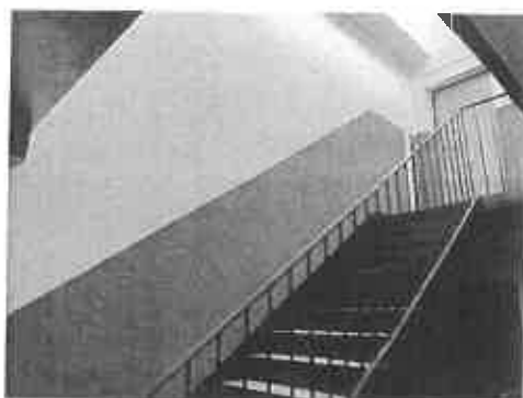
Wyremontowane klatki schodowe w budynku przy ul. Lexa 9
