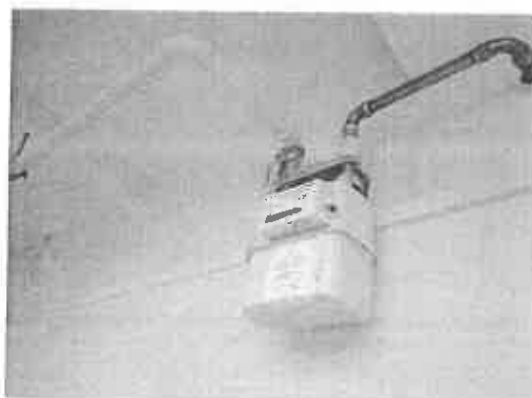
Wymiana instalacji gazowej przy ul. Energetyków 12
