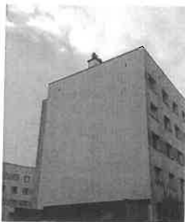
Docieplenie budynku przy ul. Gojawiczyńskiej 12
