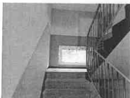
Wyremontowane klatki schodowe w budynku przy ul. Gojawiczyńskiej 4
