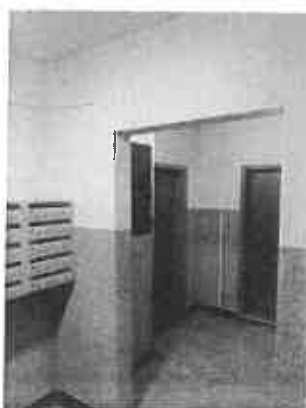
Wyremontowane klatki schodowe w budynku przy ul. Gałczyńskiego 2
