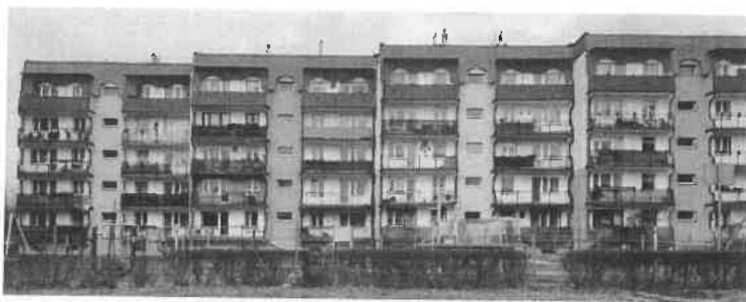
Renowacja elewacji przy ul. Leśnej 24
